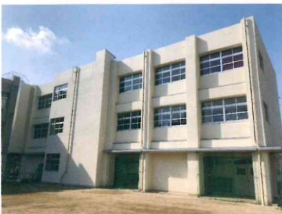
竣工した新校舎
